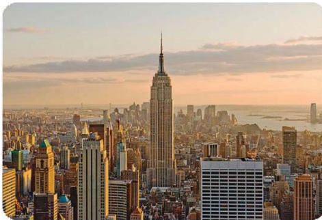
شکل ۸-۱۰ ساختمان Empire State
