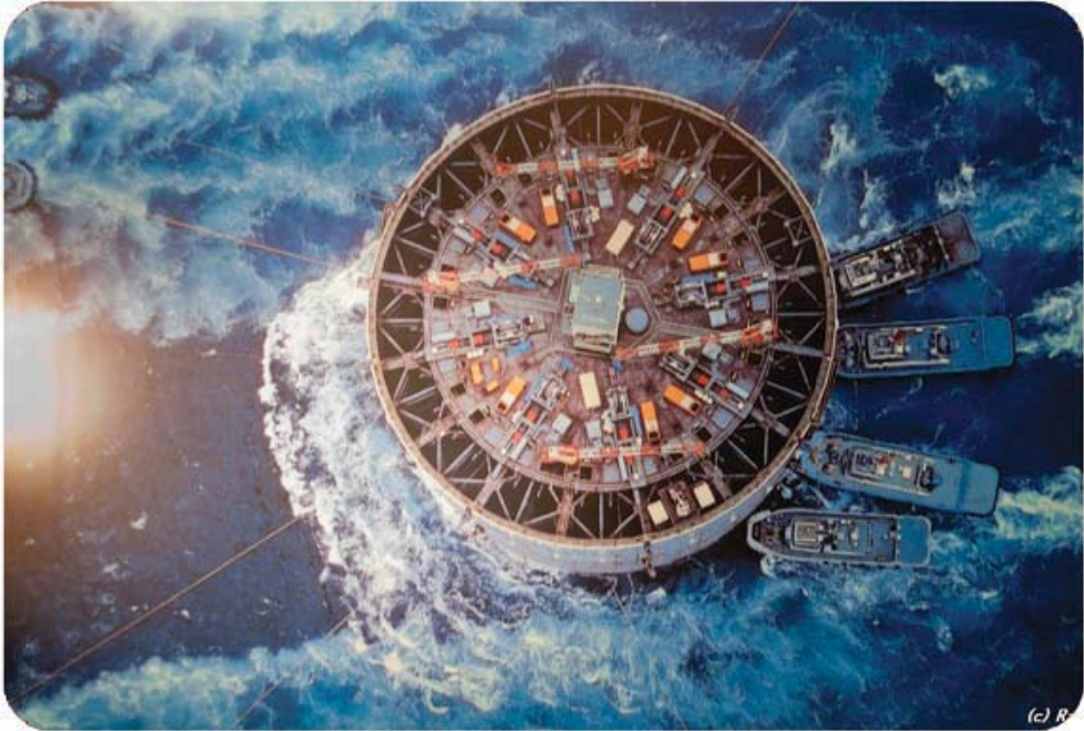
شکل ۲-۱۹ عملیات حمل و استقرار کیسون توسط ۱۲ کشتی بیدک کش (نما از بالا)
